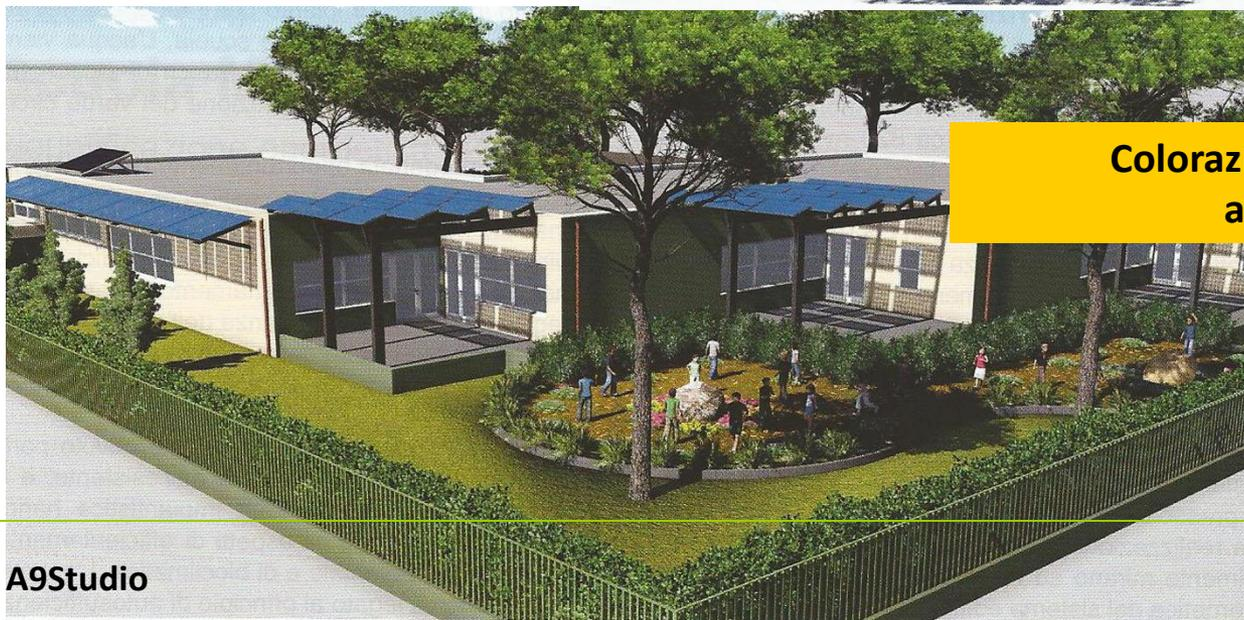
Colorazione chiara edificio per ridurre assorbimento radiazione solare
